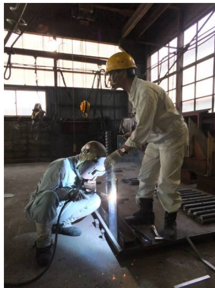
WSD490 組立溶接
