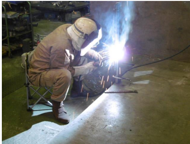
写真1 溶接作業状況
