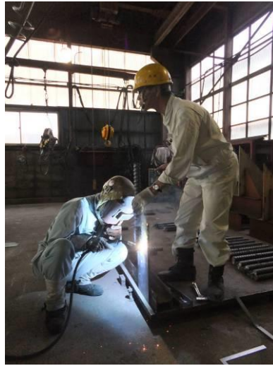
b)NewJ-BAR 組立溶接
