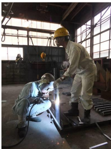
b)NewJ-BAR 組立溶接
