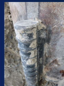
試験後溶接部状況
