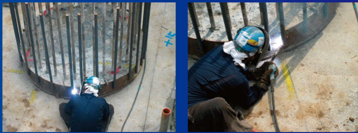
適用例(杭頭補強)
